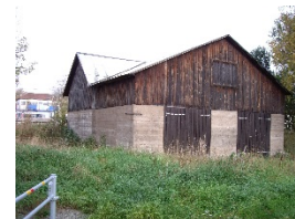
Järnvägsmagasinet i Emmaboda som användes av Åfors glasbruk för förvaring av sand och glas
