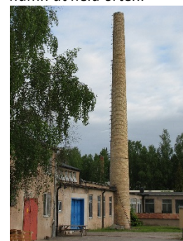
Hyttan vid Johansfors glasbruk, med den karaktäristiska skorstenen.
