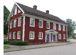
Sockenstugan i Långasjö har fungerat både som skola, kantorsbostad.
