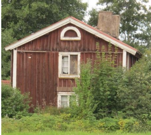
Ålderdomlig takkonstruktion med åsar samt ålderdomliga skorstenar. Välbevarade fönster och dörrar. (Dörren förefaller vara av 1930-talstyp).
