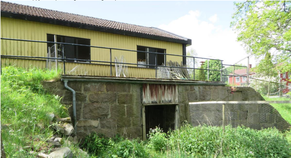
En av kasernerna är byggd på en källare.
