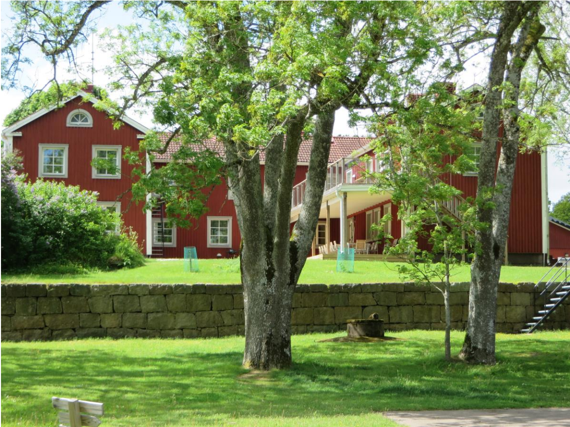
Gamla mangårdsbyggnaden (Ödevata 1:46), tillbyggd på 1920-talet. Det är viktigt att man ser de olika etapperna. Trädgården har en kallmurad stödmur.
