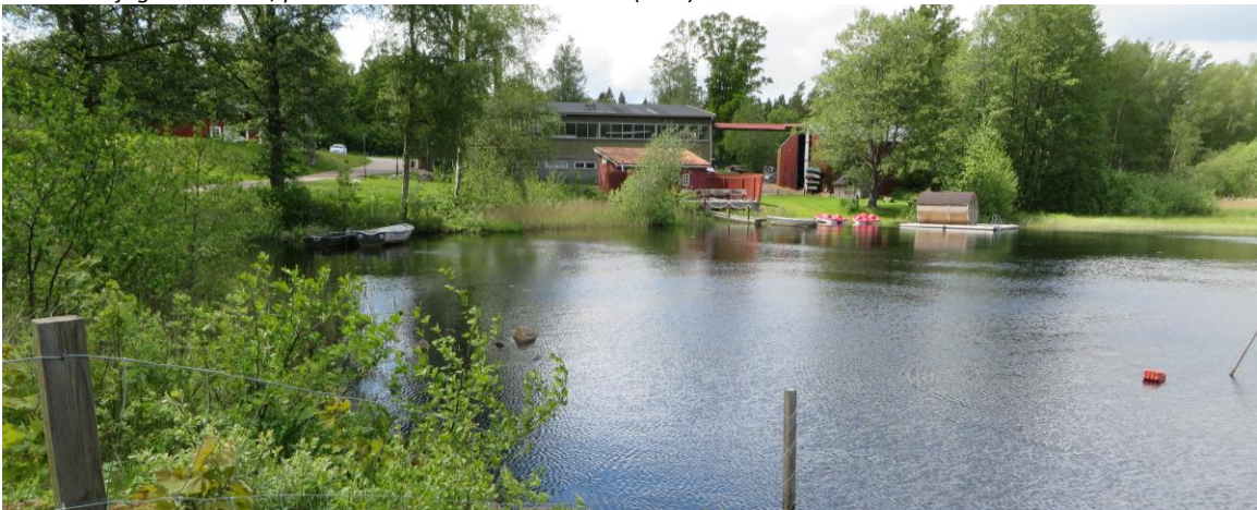
Anläggningen över sjön, från sydost. Personalens bastu och mekaniska verkstaden syns.
