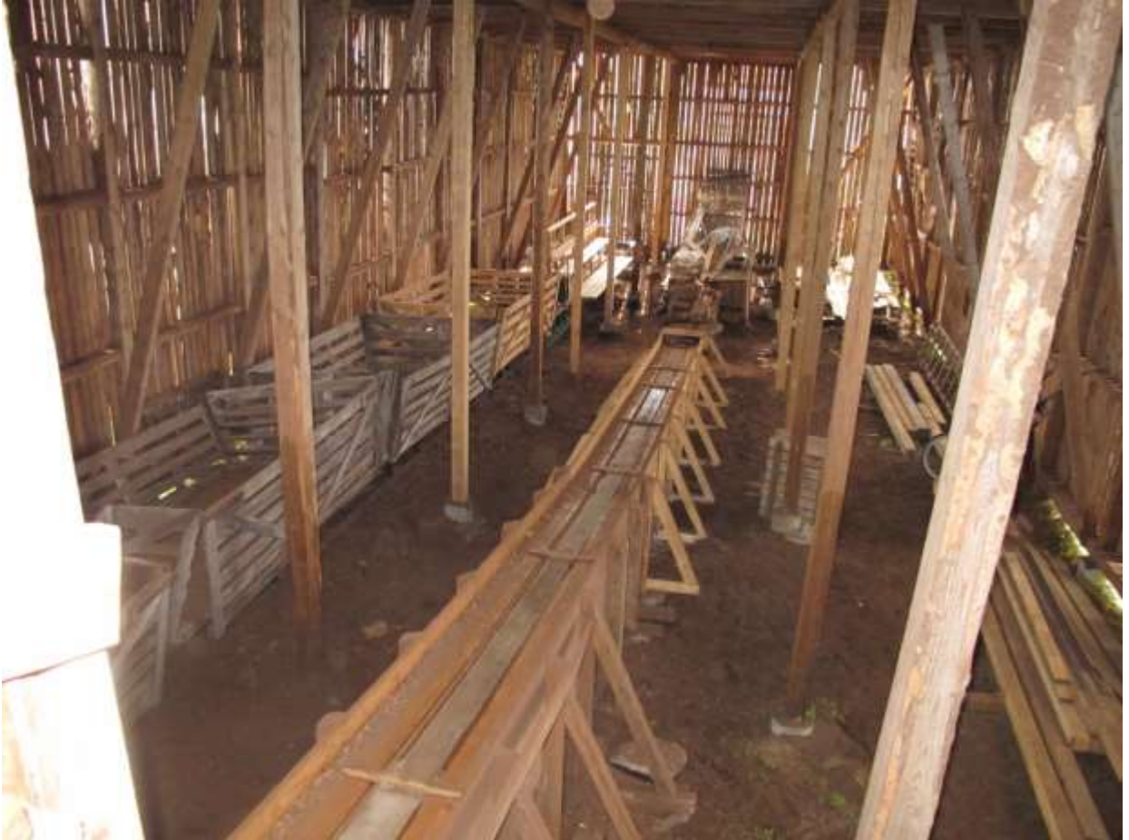
Den södra änden av den stora fabriksbyggnaden är torklada.
