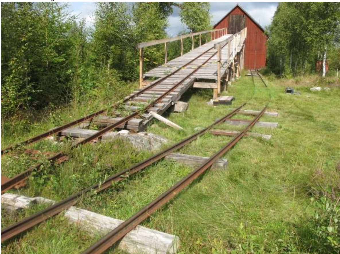
Den rekonstruerade rampen, som byggdes 2012, gör att man åter kan köra vagnarna med torv in i den stora torkladan.
