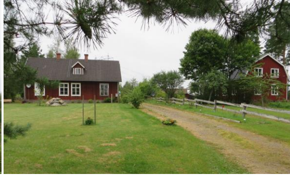
Det f.d. skolhuset och lärarbostäderna i Norra Harebo, Harebo 1:14, 1:19.
