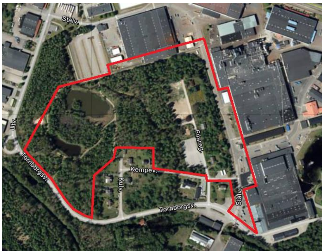
Figur 1. Ungefärligt läge för aktuellt planområde markeras med röda linjer. Norr är uppåt i bilden.
